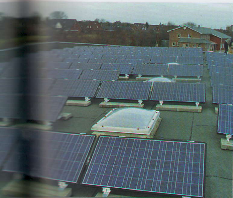
▲ Figura 1: Struttura zavorrata su tetto piano
