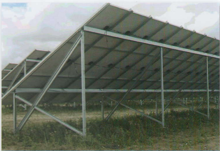
▲ Figura 9: Esempio di struttura portamoduli per impianti fotovoltaici a terra
