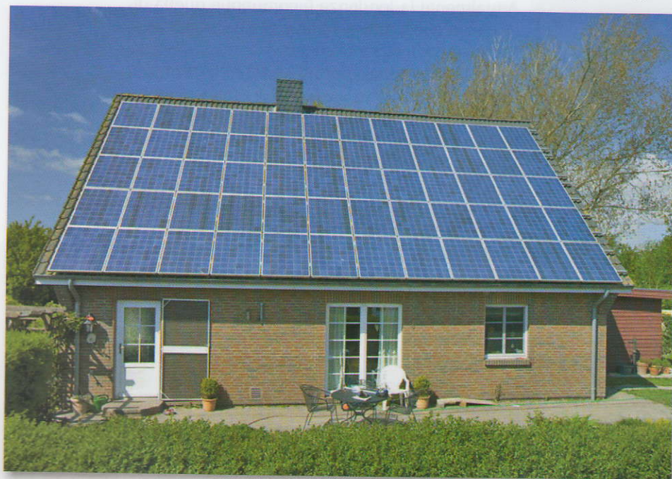
▲ Figura 6: In questo esempio i moduli fotovoltaici sono sovrapposti al manto di copertura ma il risultato ottenuto è comunque eccellente
