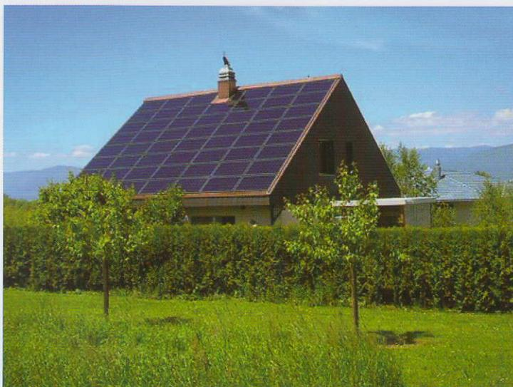
▲ **Figura 8:** Esempio di impianto fotovoltaico su falda di tetto
