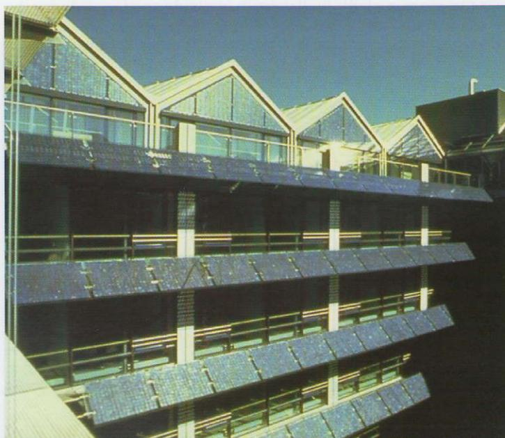
▲ **Figura 7:** Esempio di frangisole fotovoltaici
